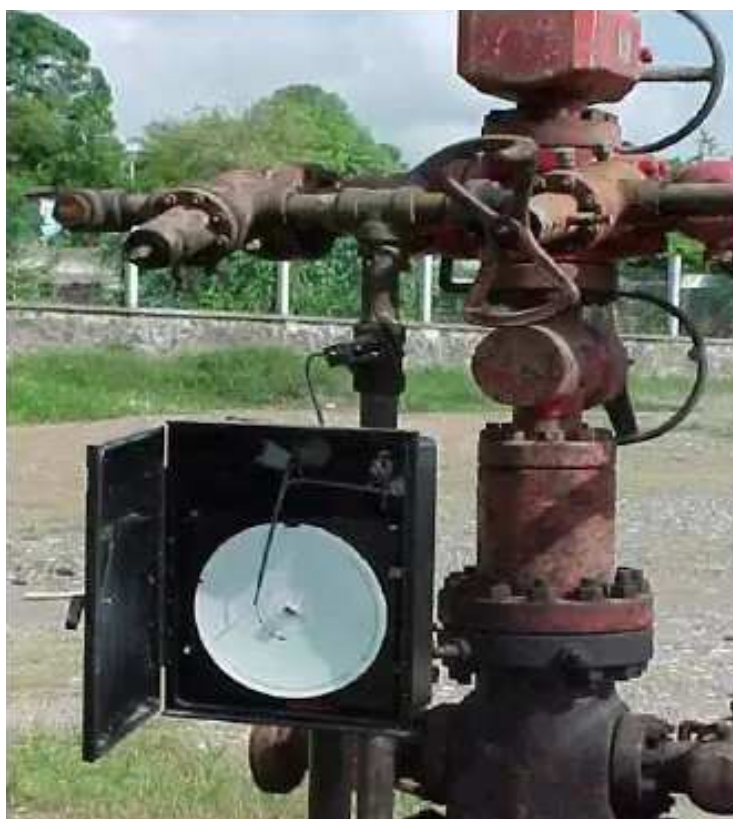
Fig.29 Toma de Presión después del Estrangulador en Manógrafos
